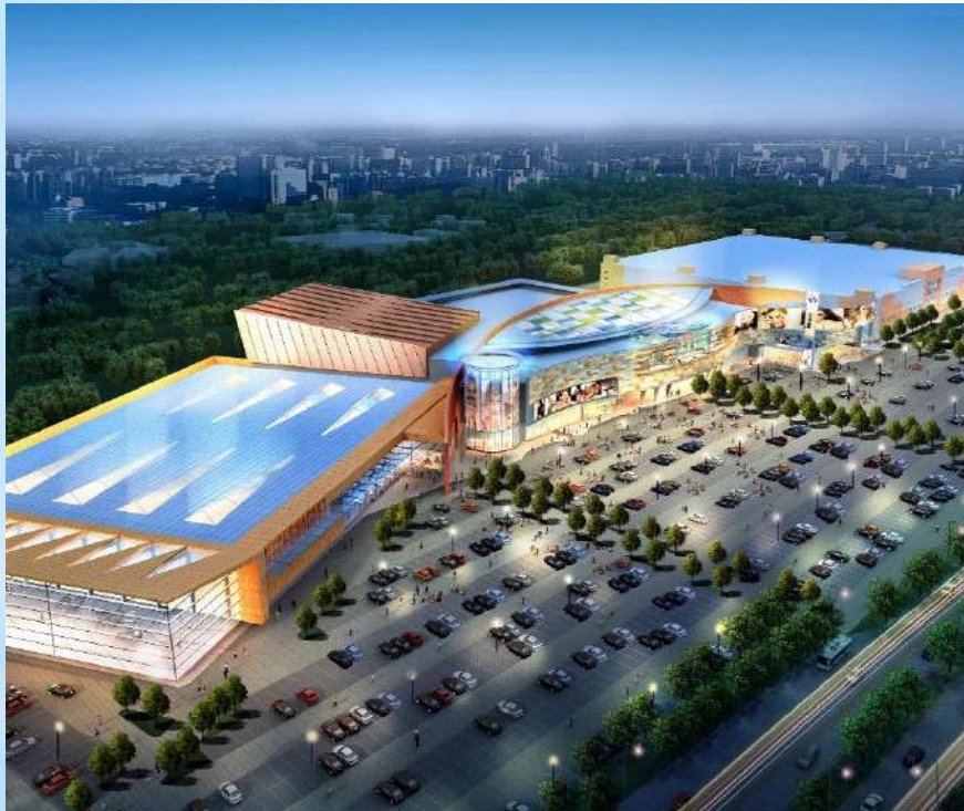
Centro Comercial y de Ocio “MEGAMAG”. Volumen de inversiones - 32,9 millones de euros
